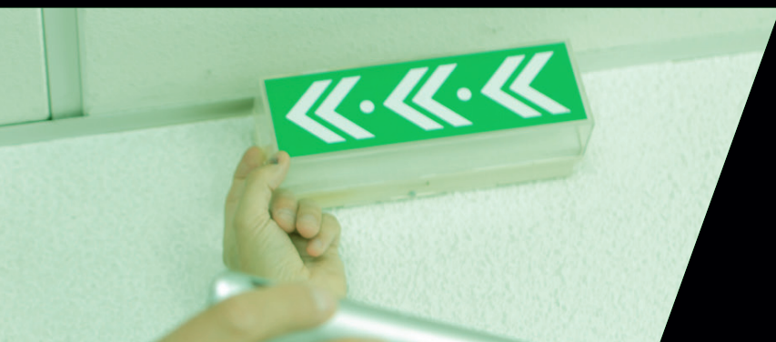
Luz de Emergência
