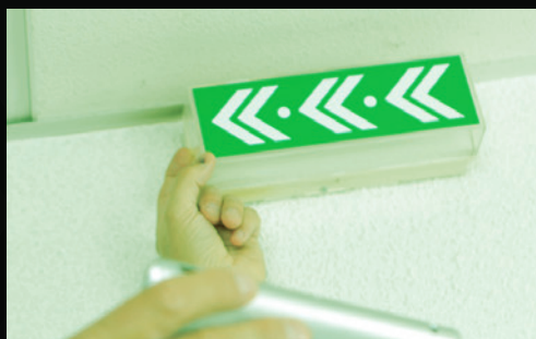
Luz de Emergência
